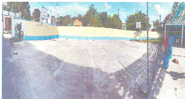
Foto 1: Bases para estructura metálica
